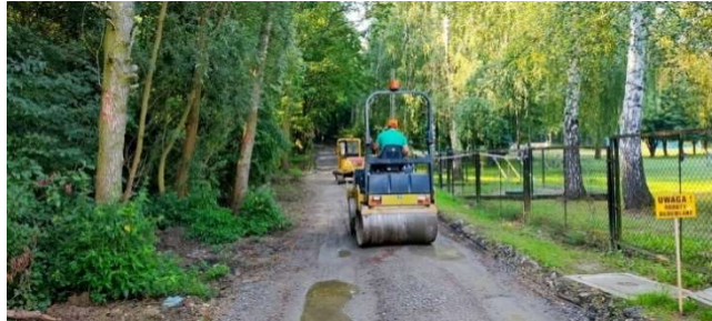
Rys 3. Prace modernizacyjne realizowane w Parku Wypoczynku i Rekreacji w Łańcucie
