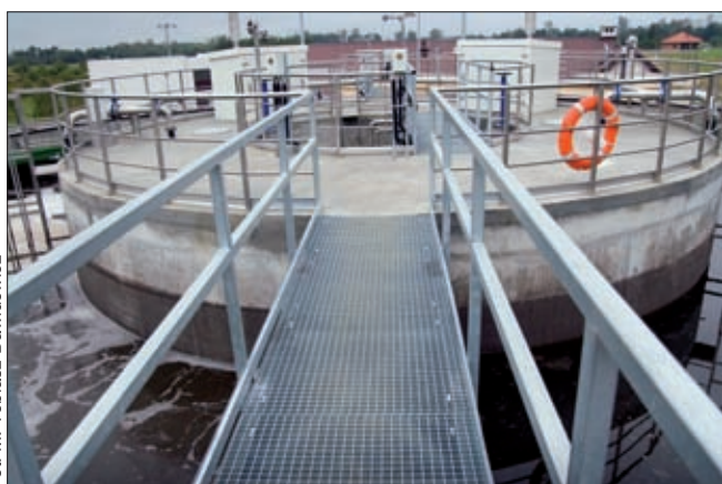
Oczyszczalnia ścieków w Jastkowicach, gm. Pysznica, przebudowana została dzięki dofinansowaniu z RPO WP.
