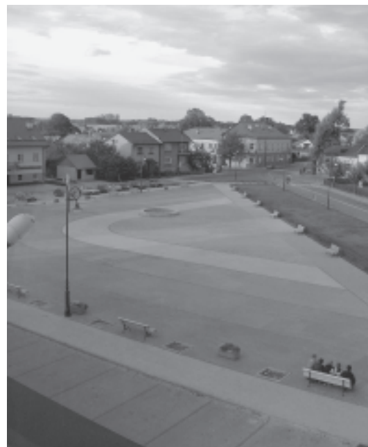
Odbudowa budynku Towarzystwa Gimnastycznego „Sokół” wraz z budową trasy turystyczno-rekreacyjnej w Radomyślu Wielkim.
