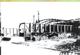
COP hala montażowa w budowie
