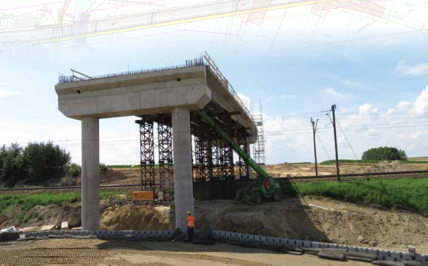
Budowa łącznika autostradowego w okolicach Przeworska, fot. PZDW
