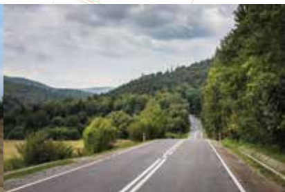
Nowy odcinek drogi 897 Tylawa-Daliowa, fot. M. Mielniczuk
