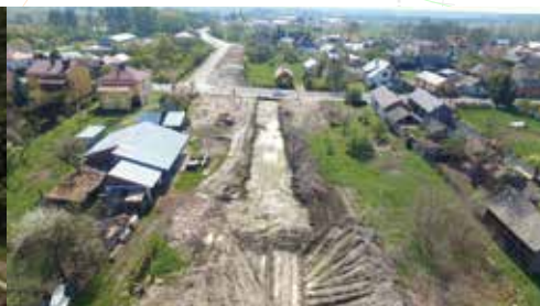
Tak powstaje obwodnica Cieszanowa, fot. PZDW
