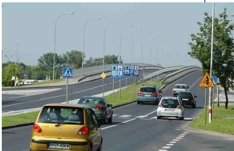
Unijne dofinansowanie w wysokości prawie 28 ml zł pozwoliło na kompleksową przebudowę wiaduktu w Stalowej Woli.
