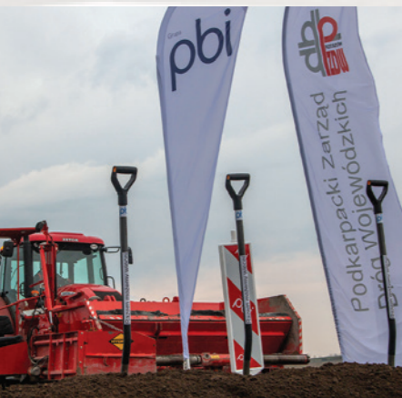
Modernizacja drogi między Zapalowem a Oleszycami jest współfinansowana z Regionalnego Programu Operacyjnego Województwa Podkarpackiego na lata 2014–2020.
